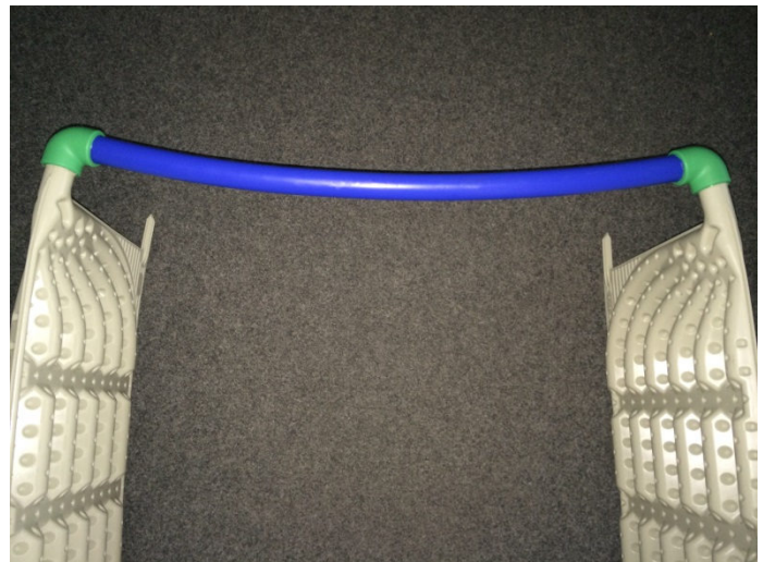
Schweißverbindung 90° Schweißmuffen am Ende muffenlosen Ende der Absorber, verbunden mit 70 cm DN 32 PP-Rohr
